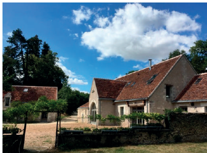
Centre d'hébergement de la Frillière
